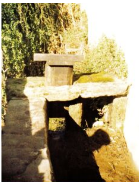
Fig. 11- Caleira com o “quebrador” semi-colocado na comporta que alimentava a roda do moinho n.º 1.
